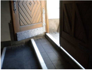
Stufe nach der Tür am Haupteingang
