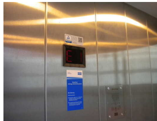
Aufzug Glasmuseum Etagenanzeige
